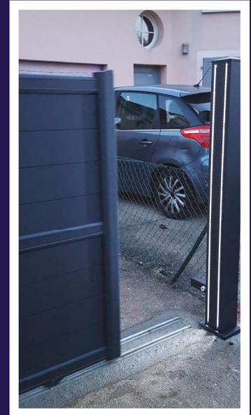
Le principe du portail télescopique repose sur le fait que ses deux vantaux coulissants viennent se positionner l'un sur l'autre en ouverture.
